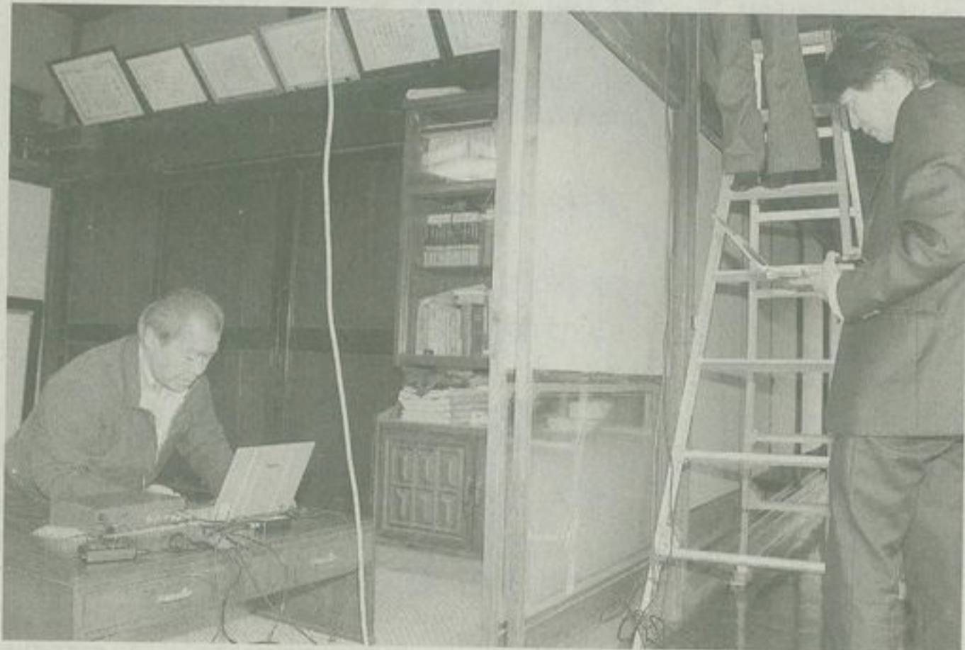
芳賀町の古民家で行われた耐震診断
